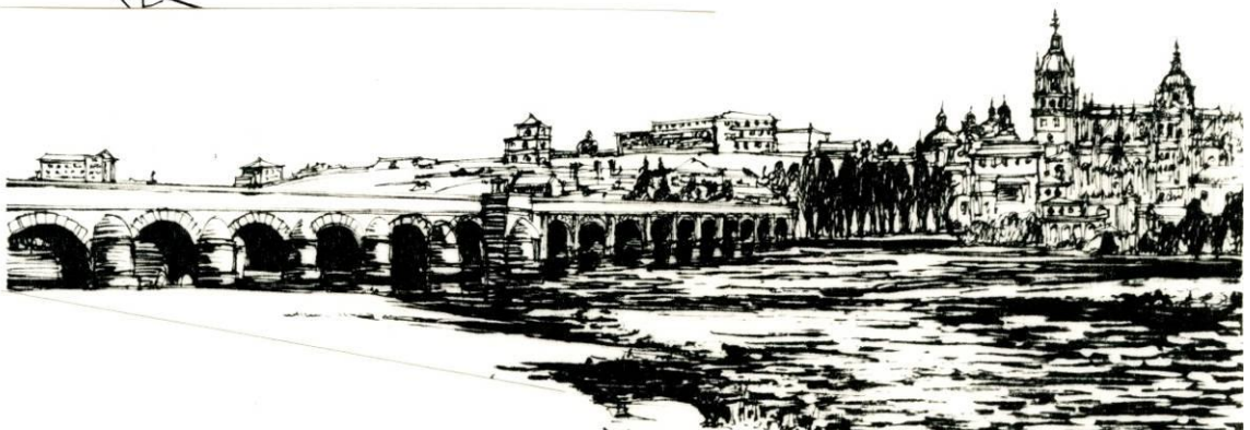
Fig. 3/212. Pont à Salamanque, Espagne, sur la rivière Tormes.
