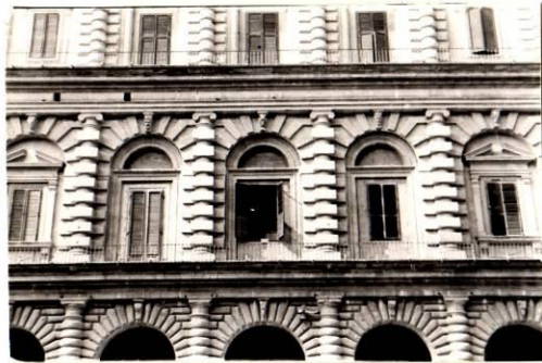
Fig 6/240: Façade arrière du palais Pitti.
