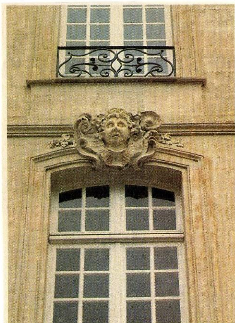
Façades réhabilitées, ornées de jolis mascarons en forme de visage humains.
