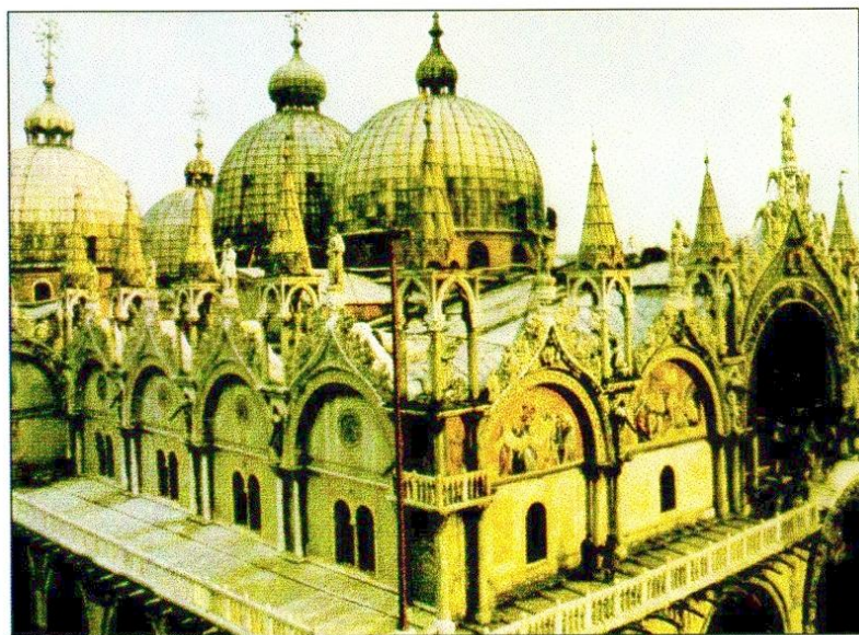
Figure 1.5 : Vue de la toiture de la basilique (Grands monuments, 2).
