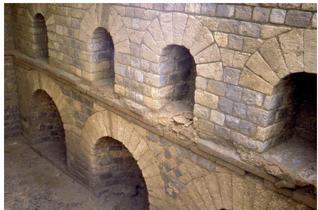
Fig. 1. Villa de Neuville «Les Machénées». Détail du mur est de la cave. Photo P. Cattelain, 1991 © Cedarc, Musée du Malgré-Tout, Treignes.
