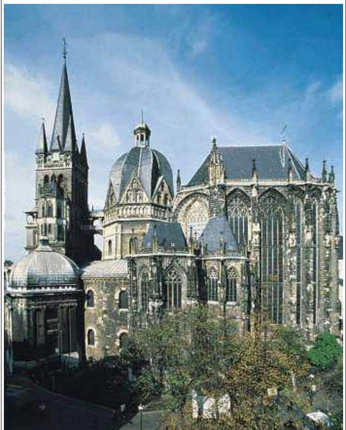
Figure 5.43 : Façade sud actuelle
