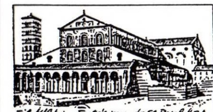
Fig. 4/9 bis. Extérieur de St Paul hors les Murs, vue du sud
