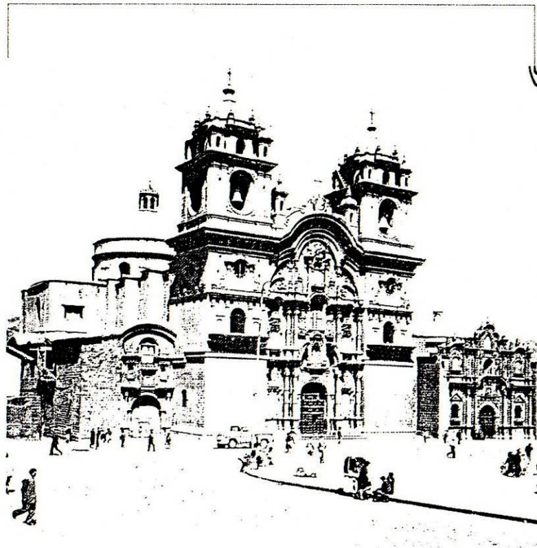
4. Eglise des Jésuites de Cuzco, Pérou, (commencée en 1651). Aussi appelée La Compania. Le dessin des tours de la façade est d'un modèle inconnu en Europe avec les 4 tourelles cantonnant les dômes qui les couronnent. La partie centrale de la façade, aussi inhabituelle, avec ses hauts arcs brisés par des fenêtres et par l'arc trèflé qui l'achève. Au-dessus de ce panneau plein de mouvements, règne un entablement brisé par un arc. L'église fût commencée en 1651 mais la façade fût construite bien après.
