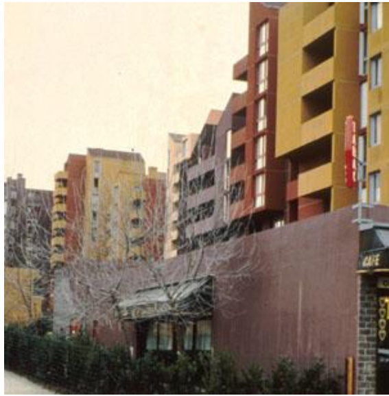
Figure 117 : quartier de Linandes à Cergy-Pontoise
