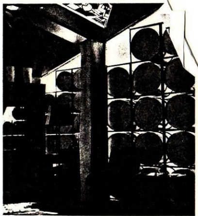
Fig. 95. Le système Drumwall, vu de l'intérieur.
