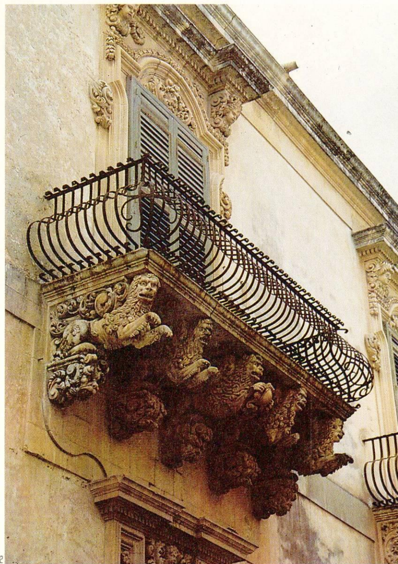
Palais Villadorata : balcons « à panse ». L'imagination des artisans.
