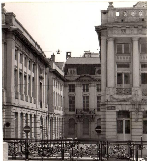
Photo n°18. Vue sur la rue du Persil.
