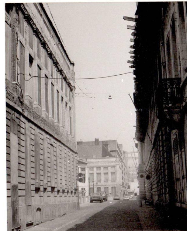
Photo n°5 Entrée rue d'Argent.
