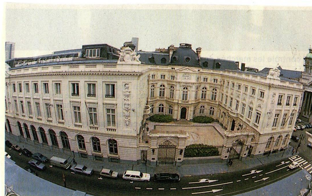
Les bâtiments du Comité supérieur de contrôle : trop de chefs ? (Photo à l'envers)
