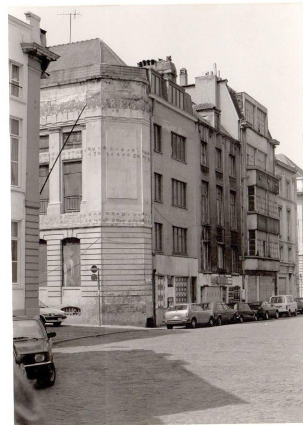
Photo n°9 Persp. des entrées rue des choux.
